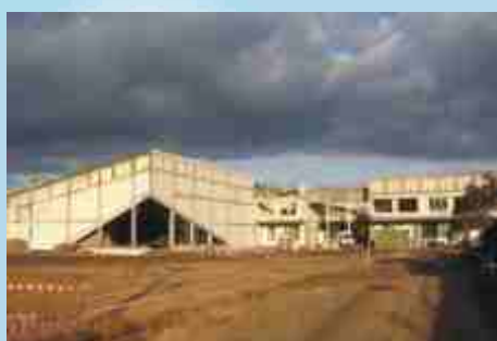
Na Osiedlu Toruńskim powstaje nowa szkoła.
