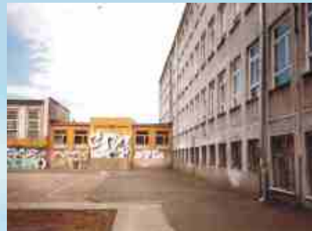
Szkoła Podstawowa nr 4 przed modernizacją.
