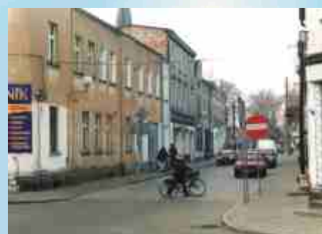
Budynki komunalne są sukcesywnie termomodernizowane.
