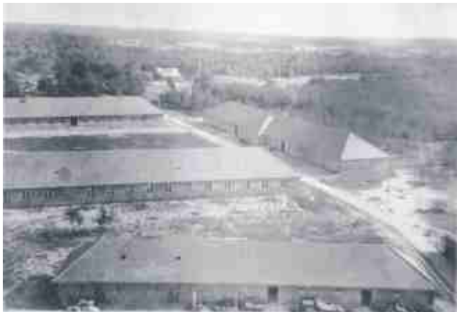
Bloki przy ul. Robotniczej w czasie budowy.
