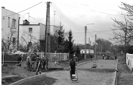
Rozpoczęła się budowa nawierzchni ulic na Osiedlu Leśnym.
